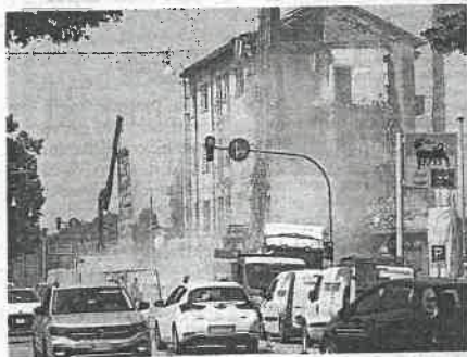
I lavori di abbattimento della palazzina in via Vicenza
